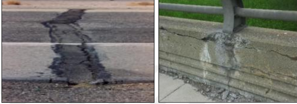
Şekil 3.34. Don etkisi nedeniyle zarar görmüş olan bir yol kaplaması ve otoyol bariyeri
