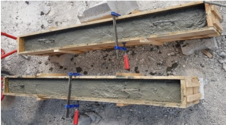
Şekil 3.16.Beton dökümü sonrası kirişler
