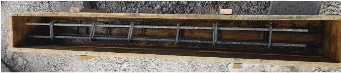
Şekil 3.13. Yağlanan kalıplara donatıların yerleştirilmesi
