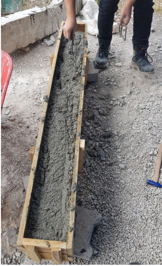
Şekil 3.15.Kirişleri taşıyabilmek için yerleştirilen kancalar
