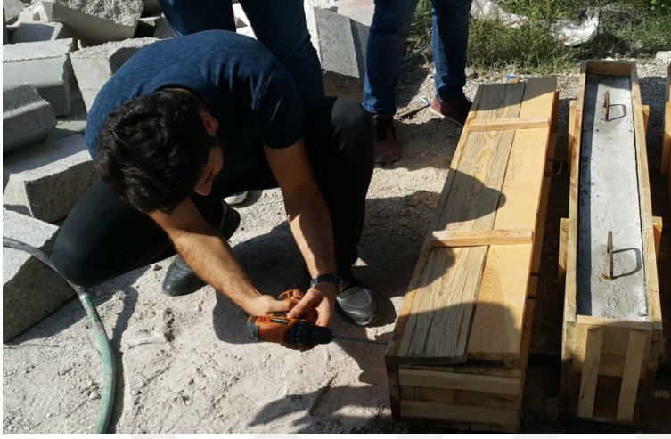
Şekil 3.17.Kalıpların sökülmesi
