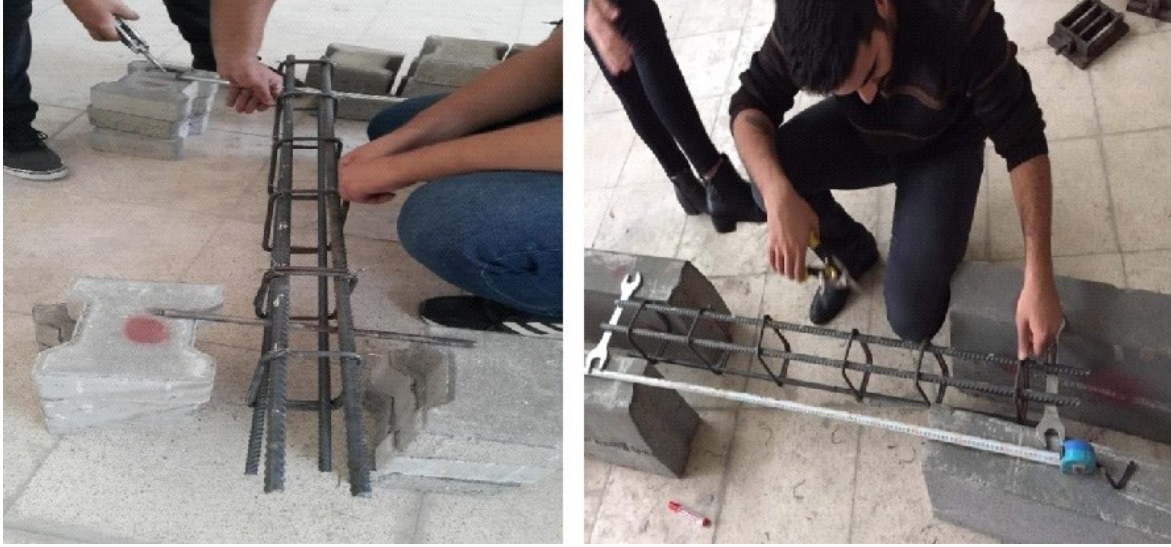
Şekil 3.12. Donatıların hazırlanması
