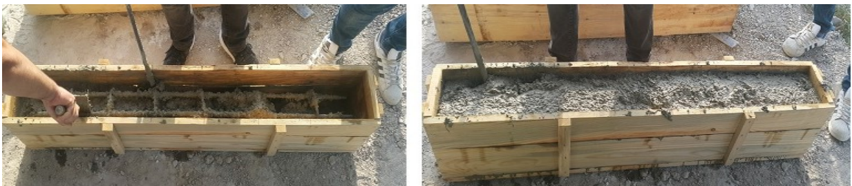
Şekil 3.14. Betonun kalıplara yerleştirilmesi
