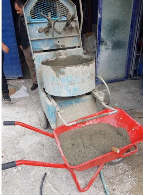
Şekil 3.3. Beton karma mikseri ile beton karışımlarının hazırlanması
