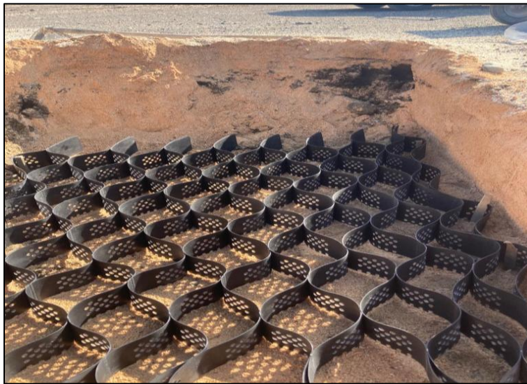
Resim 4.11. Geohücrenin yerleştirilmesi ve çubuk yardımıyla sabitlenmesi
