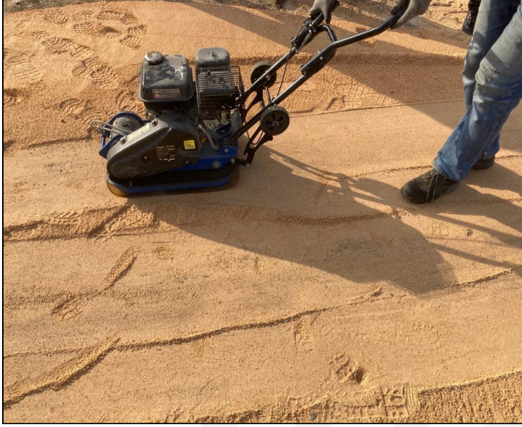
Resim 4.12. Kompaktör ile sıkıştırma işlemi
