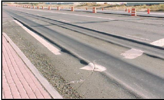
Resim 3.6. Tekerlek izi oluşumu ve oluklanma
