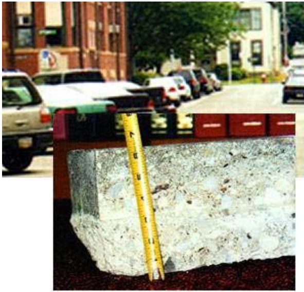
Resim 3.1. Ohio'da halen kullanılan beton yoldan alınan numune (Pancar, 2008)
