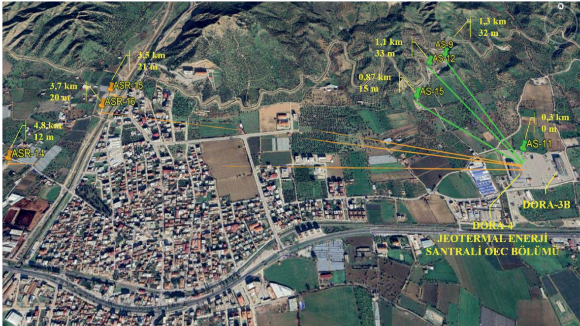
Resim 4.1. DORA-4 Jeotermal enerji santralinin yerleşim krokisi
