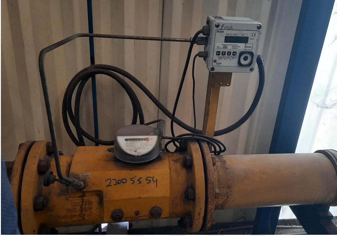
Resim 4.2. EK220 gaz debimetresinin gerçek görünümü
