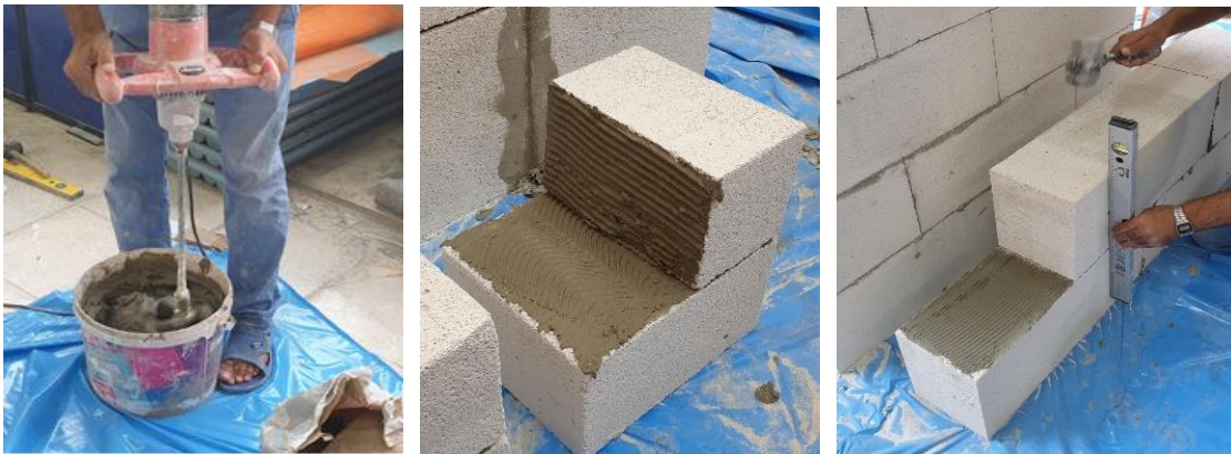
Şekil 2.2. Duvar numunelerinin imalat aşaması
