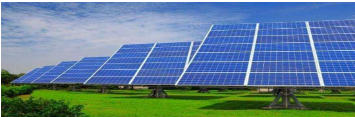
Şekil 3.15. Güneş enerjisi santrali [20]
