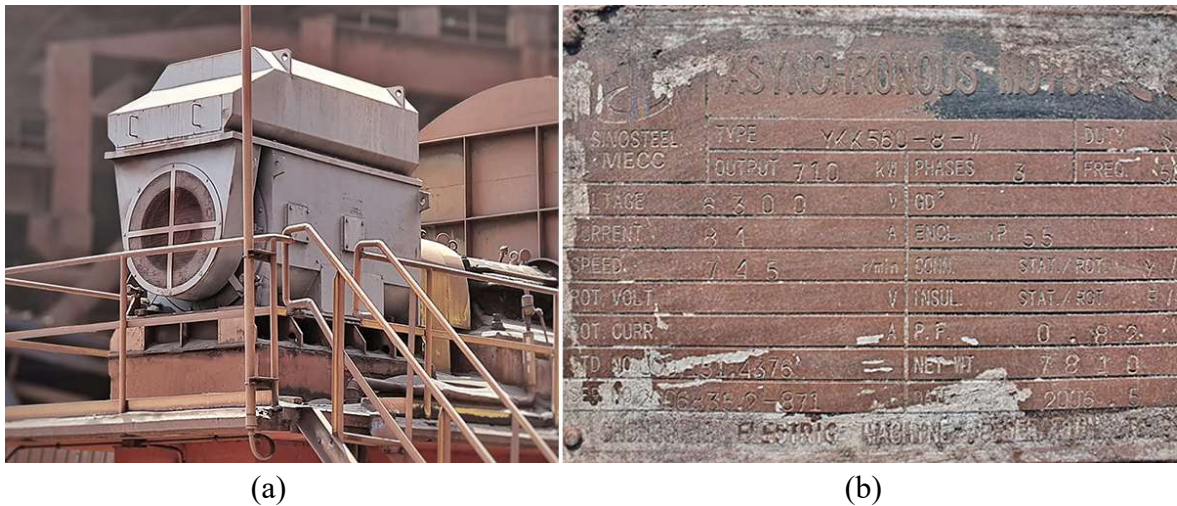
Resim 3.4. (a) Sinter fabrikası dairesel soğutucu C200 fan motoru (b) ASM etiketi
