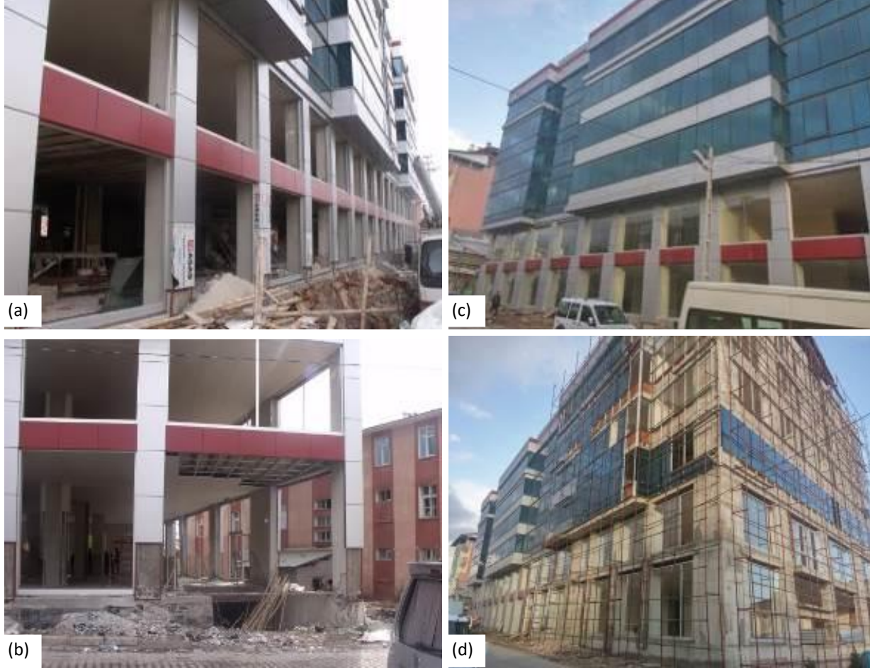
Şekil 5. İncelenen yapının hasarlı hali (a, b) ve güçlendirme sonrası (c, d) görüntüleri
