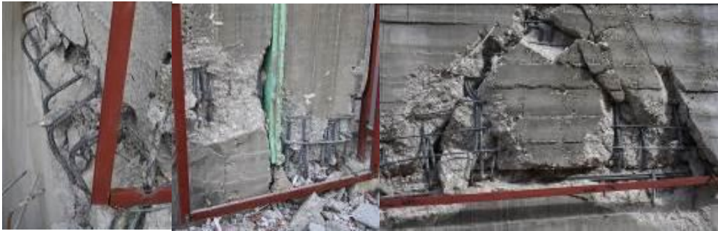
Şekil 1. Yapıdaki hasara ait örnek görüntüler
