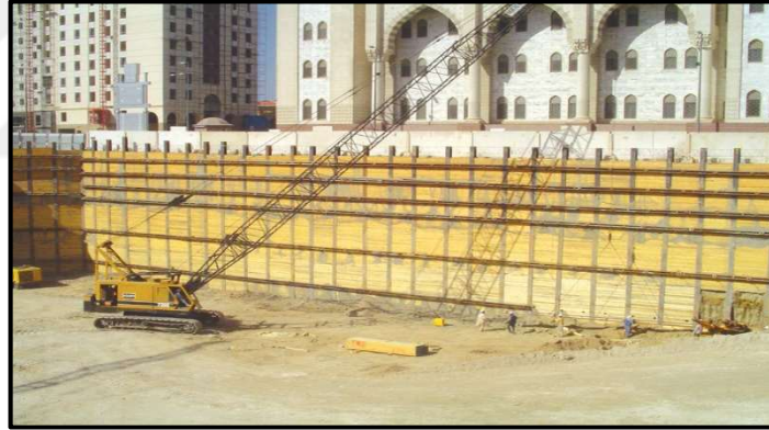
Şekil 3.3 Ahşap palplanş
