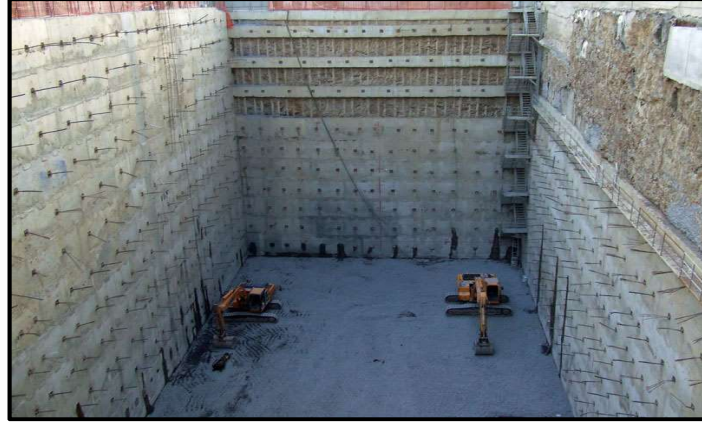
Şekil 3.4 Betonarme palplanş
