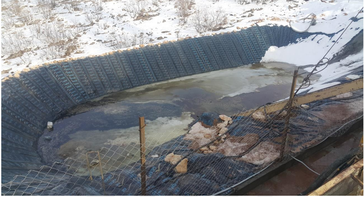
Resim 4.6. Etrafı güvenlik şeridi ile çevrilmemiş mudpit çukuru
