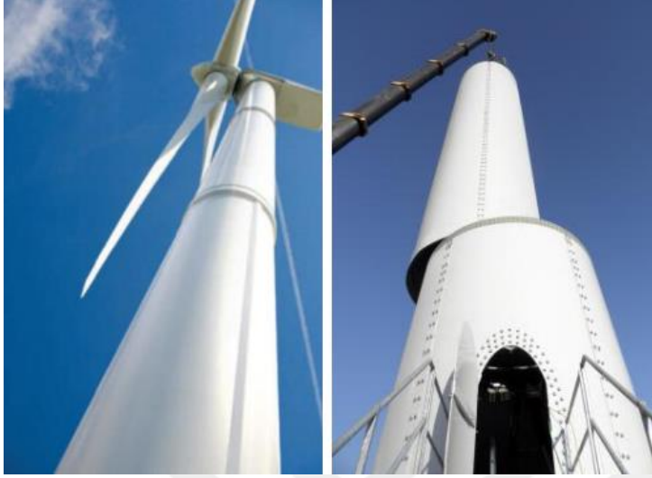
Şekil 3.11. Türbin kulesi ve montajı, (Chantharasenawong vd, 2011)
