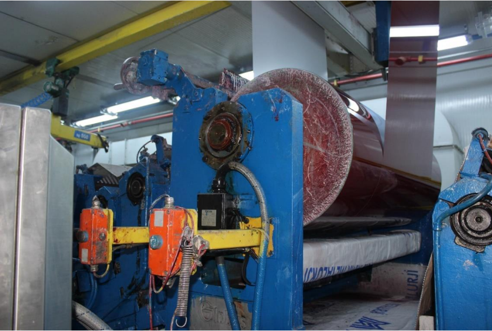
Resim 3.19. MMK Metalurji boyama hattı son kat boya uygulaması
