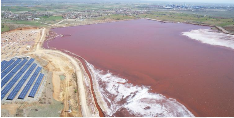
Şekil 3.15. Kırmızı çamur atık barajı [90]
