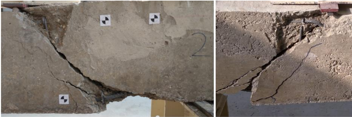
Şekil 4.4. DYNØ6 çatlak ayrıntıları
