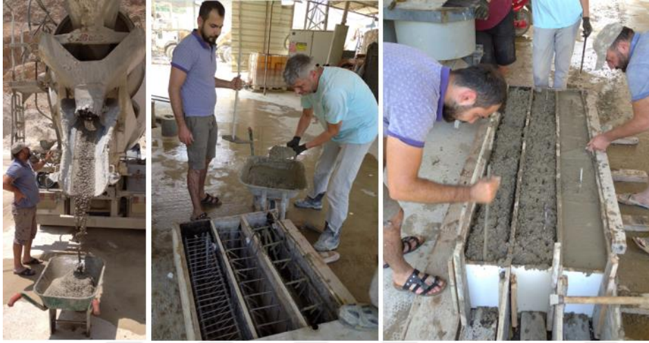
Şekil 3.12. Beton dökümü ve betonun şişlenmesi
