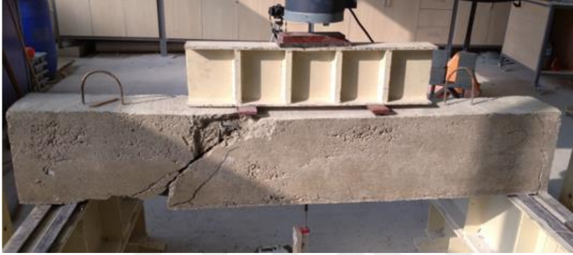
Şekil 4.3. DYNØ6'nın göçmüş hali
