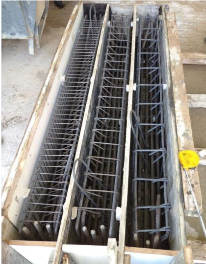
Şekil 3.11. Deney numunelerinin kalıba yerleştirilmesi
