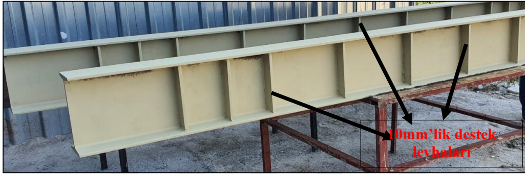
Resim 5.25. IPN240 üzerine yerleştirilen destek levhaları
