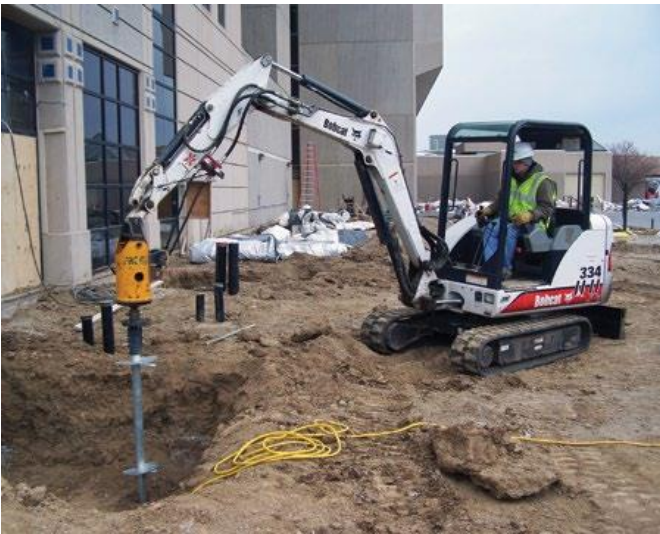
Şekil 2.16. Yeni yapı helisel kazık montajı (Blessen vd., 2019)
