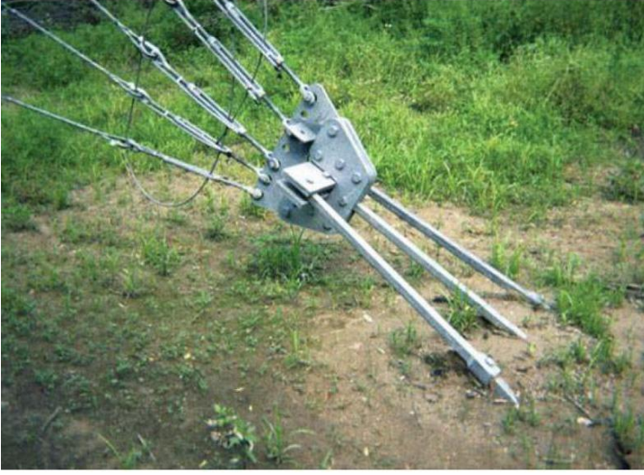
Şekil 2.8. Gergi kablosu ankrajları (Perko, 2009)
