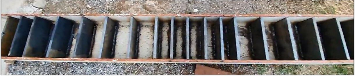
Resim 5.27. HEA300 kirişi iç kısımlara 20mm'lik destek levha uygulaması
