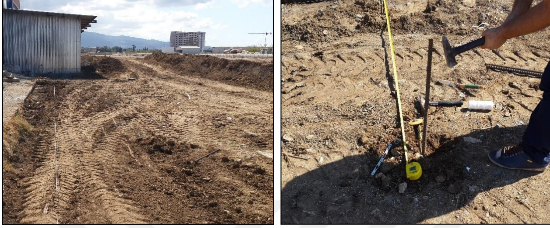
Resim 5.20. Arazi yüzey düzeltmesi ve kazık yerlerinin işaretlenmesi
