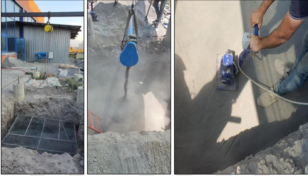
Resim 5.40. Deneysel kumunun doldurma ve sıkıştırma işlemleri
