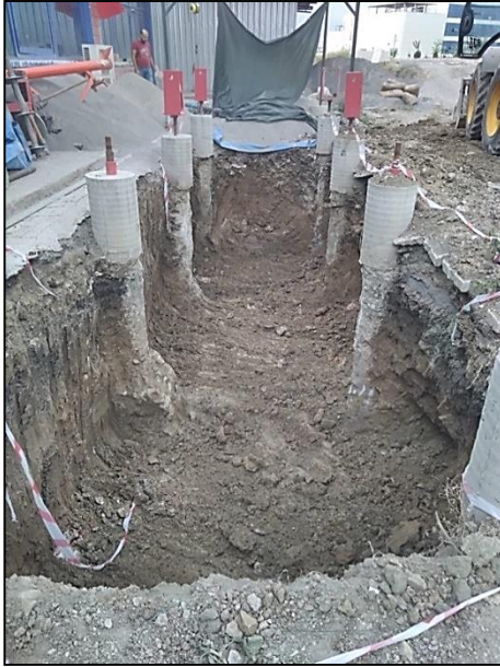
Resim 5.37. Deney havuzlarının kazı aşaması
