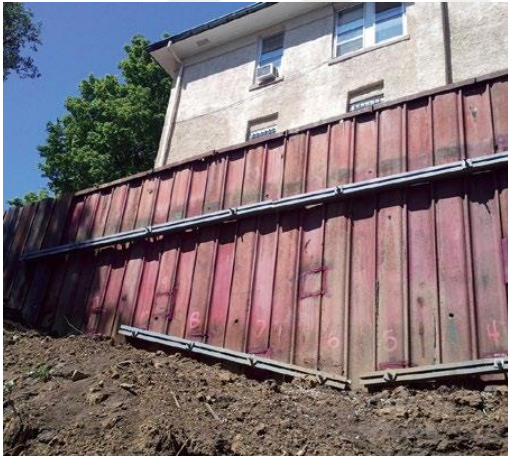
Şekil 2.18. Helisel ankrajlar ile tarihi bir evin palplanş duvar stabilizasyonu (Blessen vd., 2019)
