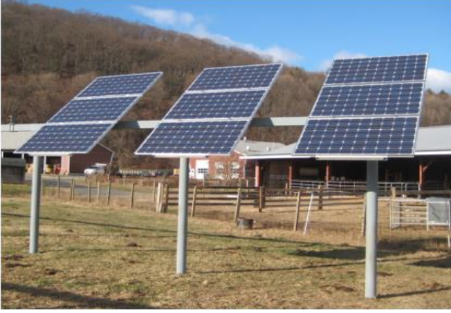
Şekil 2.11. Helisel kazıklar üzerine kurulmuş güneş paneli (Lutenegger, 2017)
