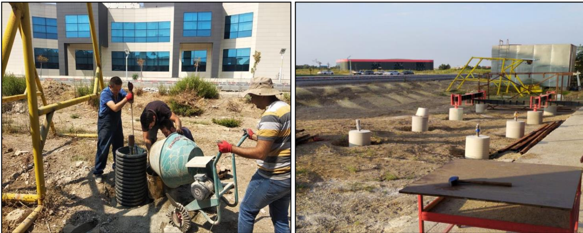
Resim 5.24. Reaksiyon kazıklarında başlık betonu imalatı
