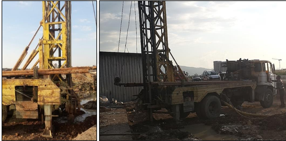
Resim 5.21. Reaksiyon kazıkları delgi aşaması
