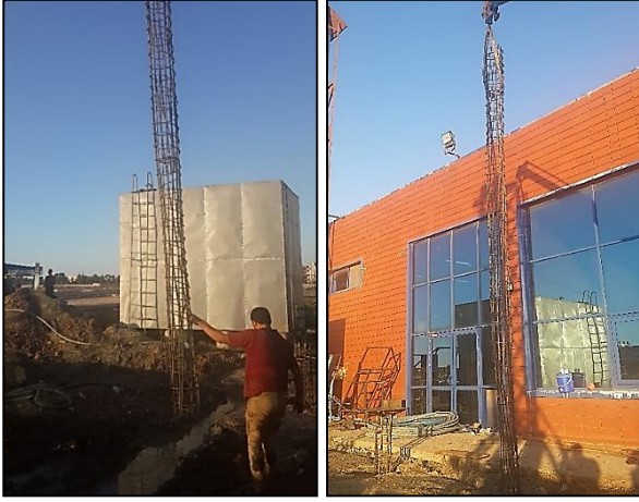
Resim 5.22. Reaksiyon kazıklarında donatıların delgi içerisine yerleştirilmesi
