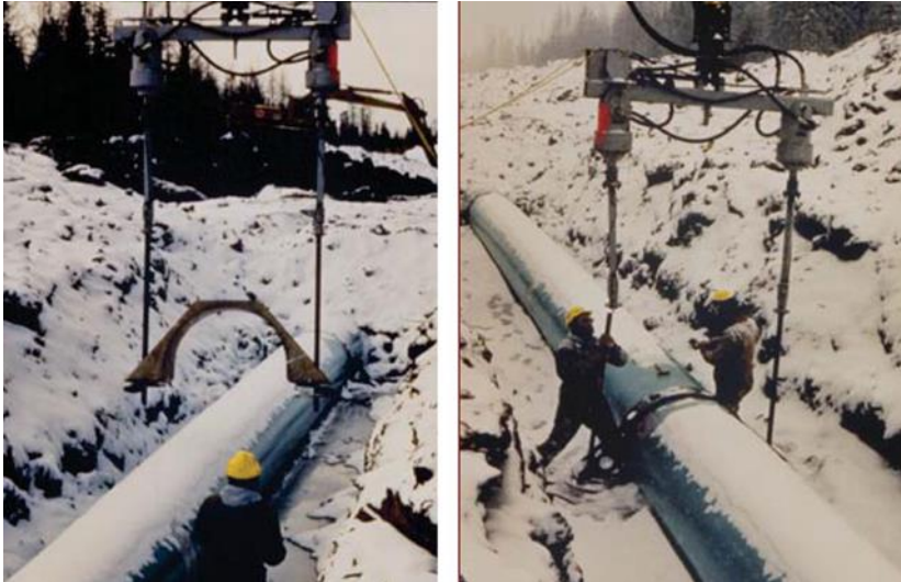
Şekil 2.7. Boru hatları helisel ankraj uygulaması (Yılmaz, 2016)
