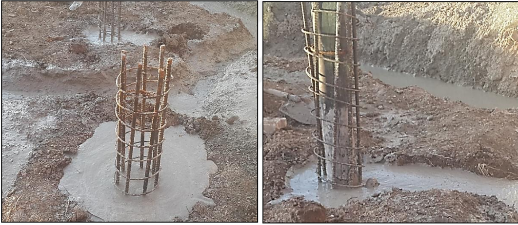
Resim 5.23. Reaksiyon kazıklarında betonlama işlemi
