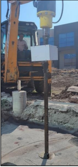
Resim 5.43. Helisel kazık montajı
