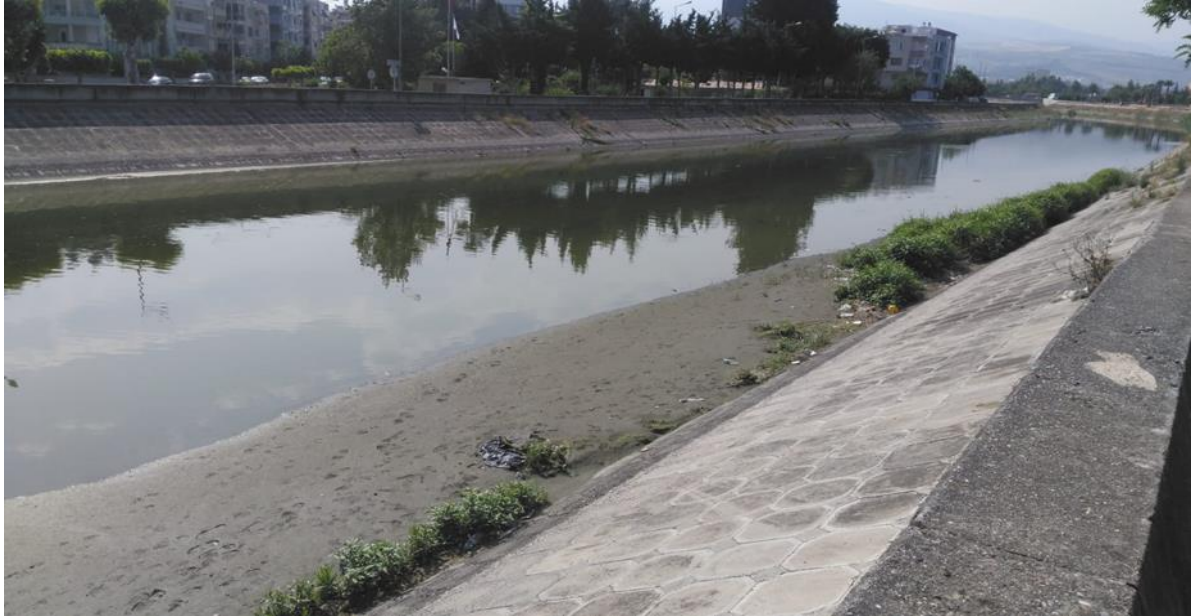
Resim 3.1. İskenderun ilçe merkezinde bulunan kanal
