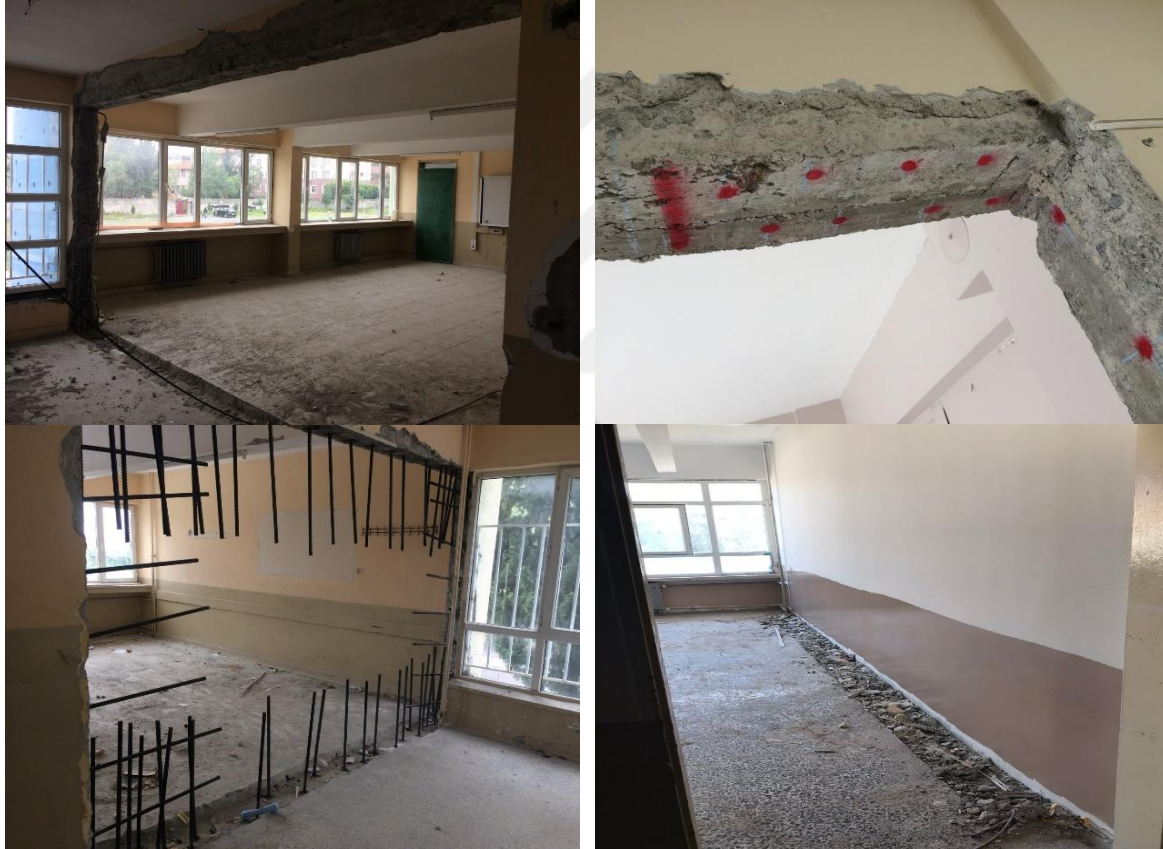
Şekil 3.10. Dörtüol Anadolu lisesi perde duvar uygulaması aşamaları
