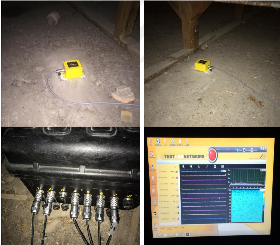
Şekil 3.15. Dört yol Anadolu Lisesi titreşim kayıtlarının alınması
