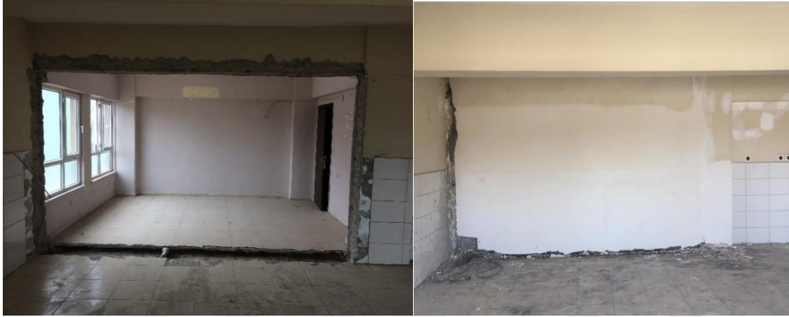
Şekil 3.13. İskenderun Ticaret ve Sanayi Odası İlkokulu perde duvar uygulaması aşamaları
