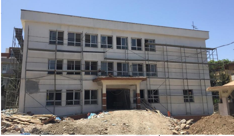
Şekil 3.11. İskenderun Ticaret ve Sanayi Odası İlkokulu binası görünüşü
