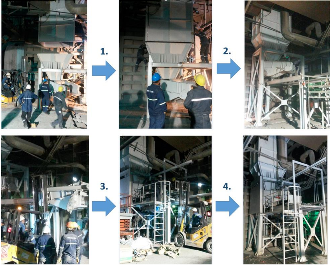
Şekil 4.2. Külçe alüminyum besleme sistemi montaj aşamaları
