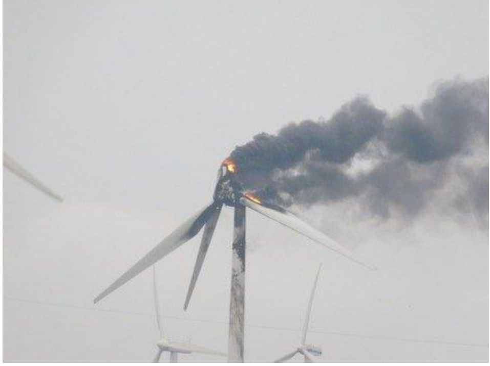
Şekil 3.30. Yıldırım Çarpmış Bir Rüzgâr Türbini
