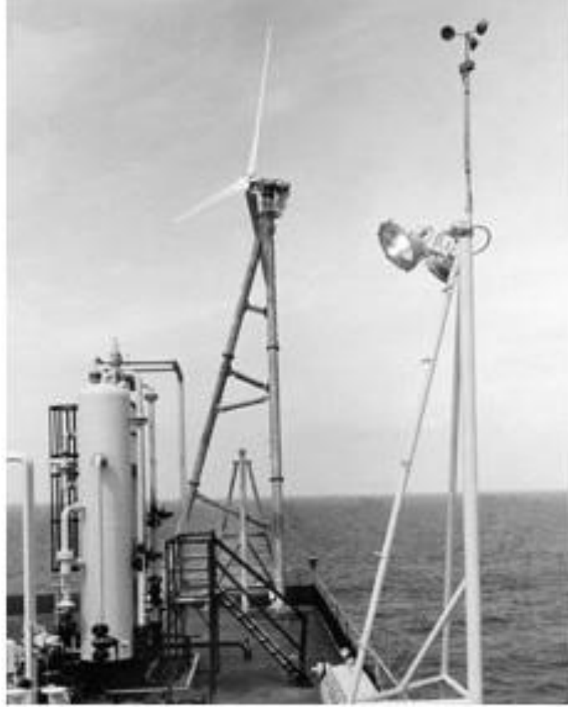
Şekil 1.2. Petrol Platformuna Kurulu Türbin
