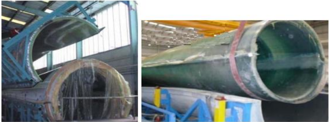
Şekil 3.27. Kanat Kalıbının Sökülmesi
